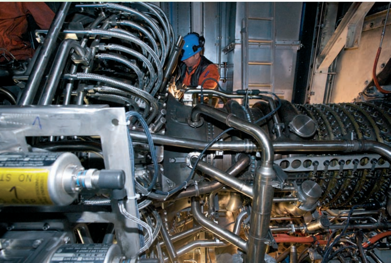
In december 2008 zijn de hete delen van de gasturbine vervangen.
